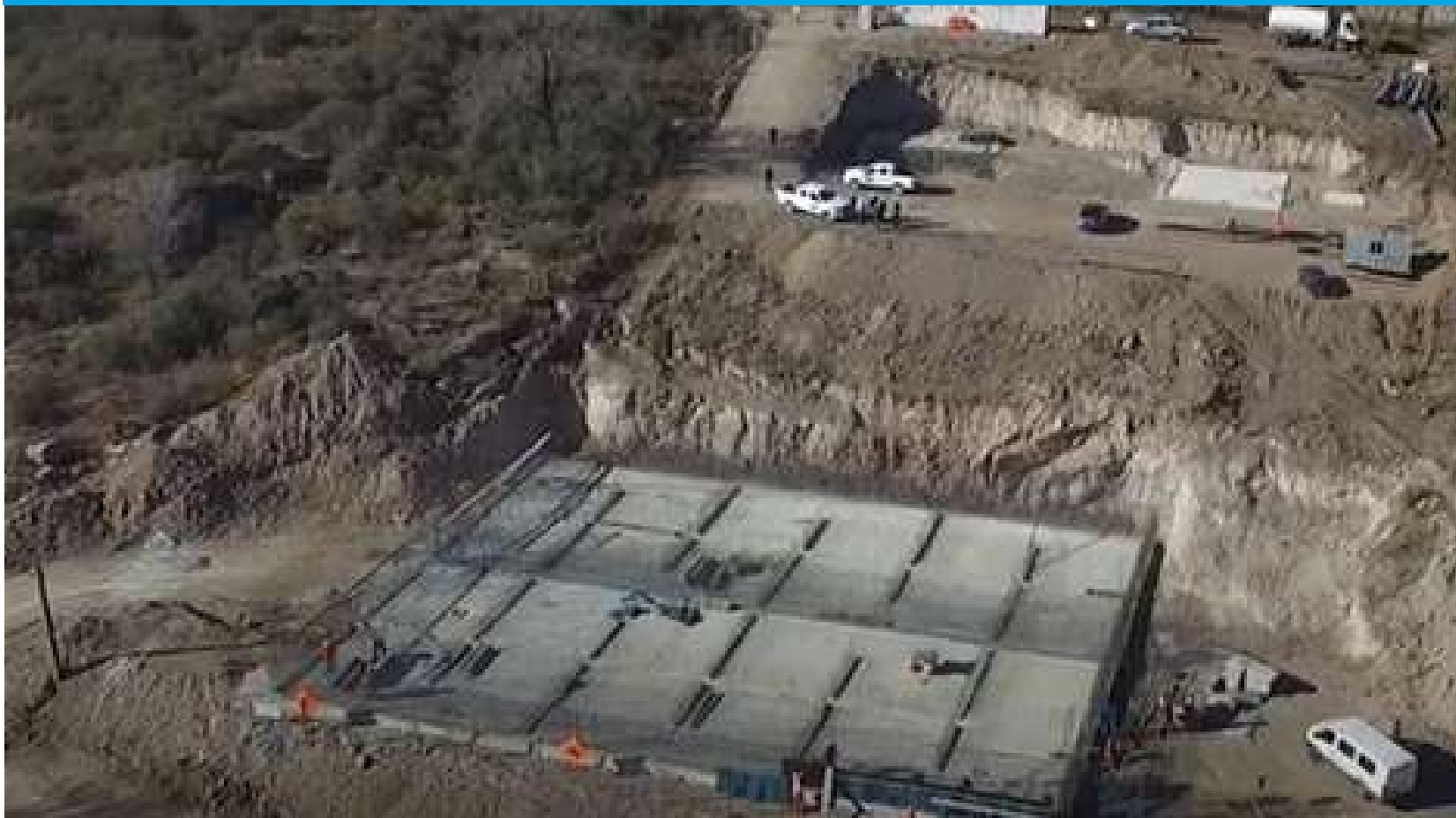
Aqueduct in Punilla Sur
